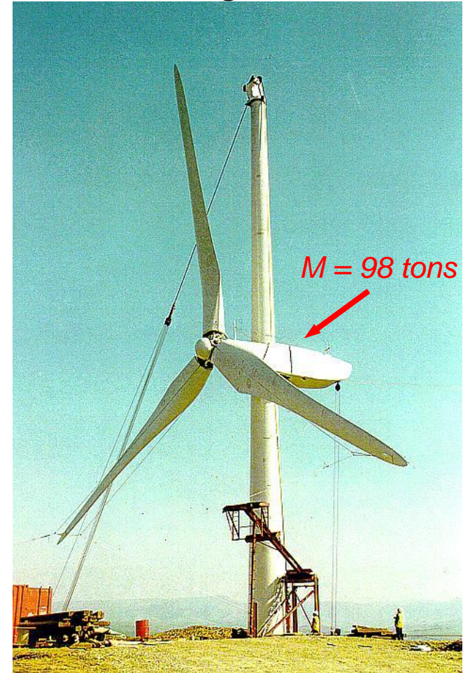
Installing a nacelle
