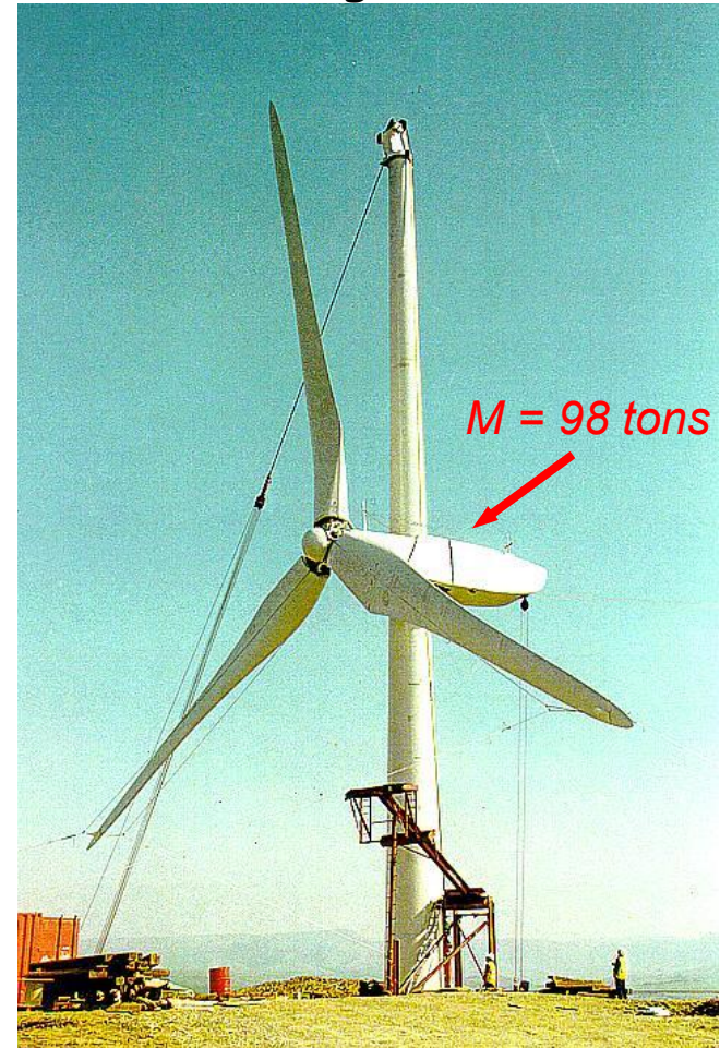
Installing a nacelle
